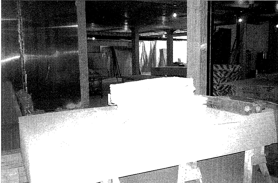
Figur 48. Lagring av gips inomhus på bockar
