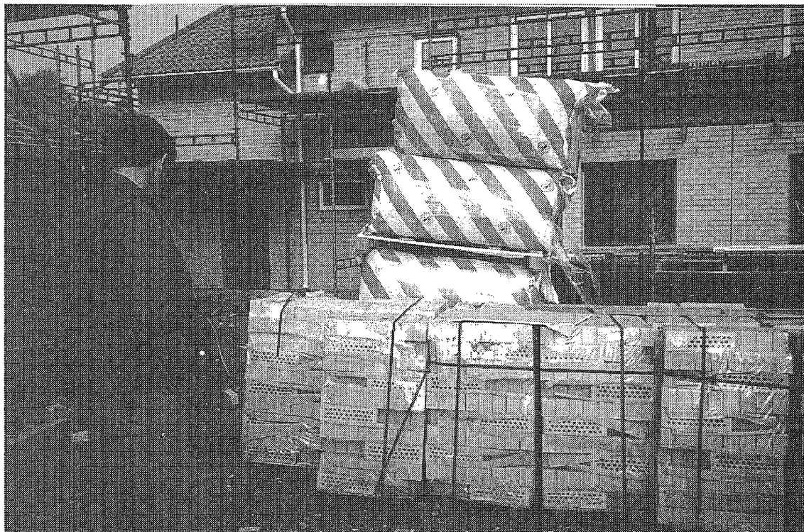
Figur 31. Lagring av tegel på pallar utomhus
