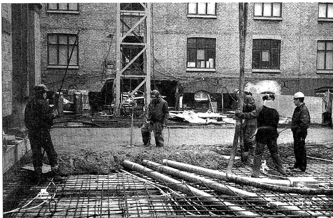
Figur 26. Gjutning av terrassbjälklag
